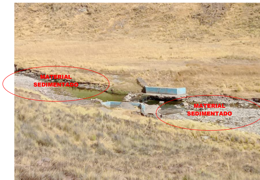
FIGURA N°02: MATERIAL COLMATADO EN EL CAUCE DEL RÍO CHECCA, CON UNA PROFUNDIDAD PROMEDIO DE 0.30 M. ESTO PROVOCA EROSION Y SOCAVAMIENTO AL AZUD Y MARGEN DERECHA.
